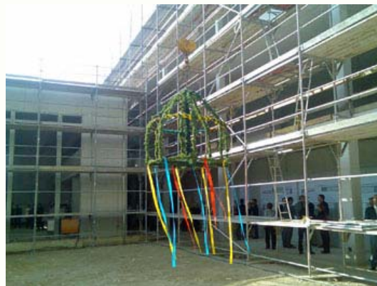
Richtfest Neubau FH Mainz
